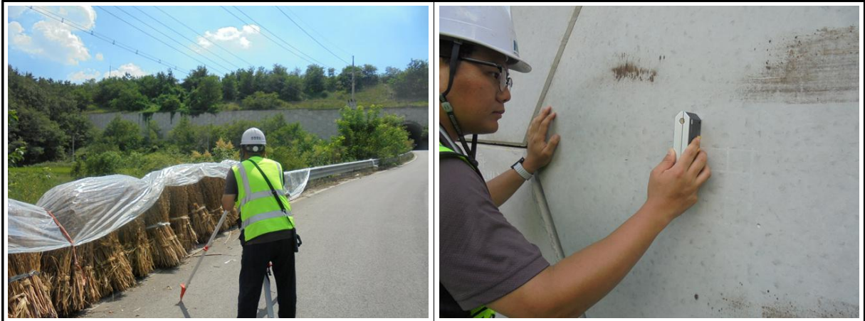
【사진 13.4.2】 측량작업 전경
