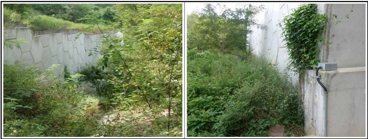
【사진 13.3.1】 지반, 기초부 전경
